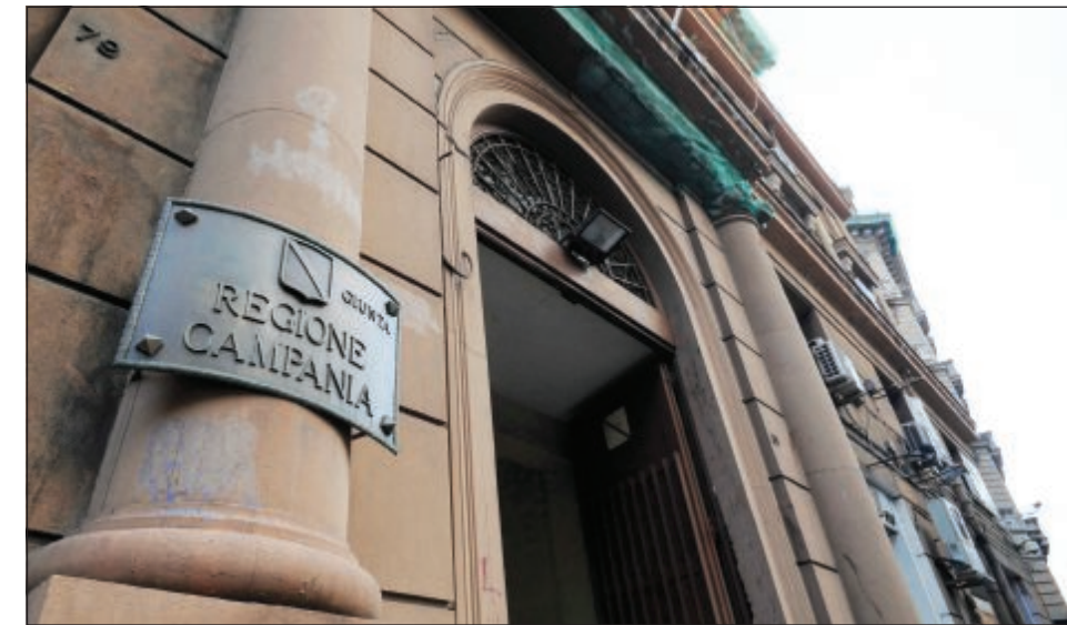
Palazzo Santa Lucia, sede della giunta regionale della Campania
